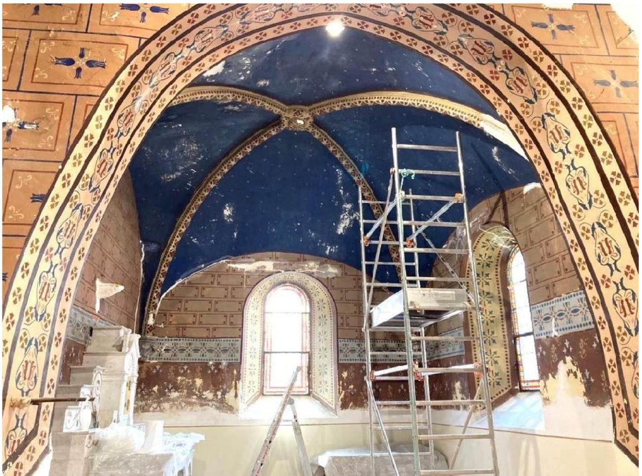
Travaux de consolidation des peintures et comblement des fissure en cours
